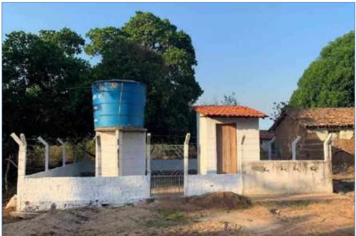
SISTEMA ALTERNATIVO DE TRATAMENTO DE ÁGUA NA LOCALIDADE VITÓRIO
