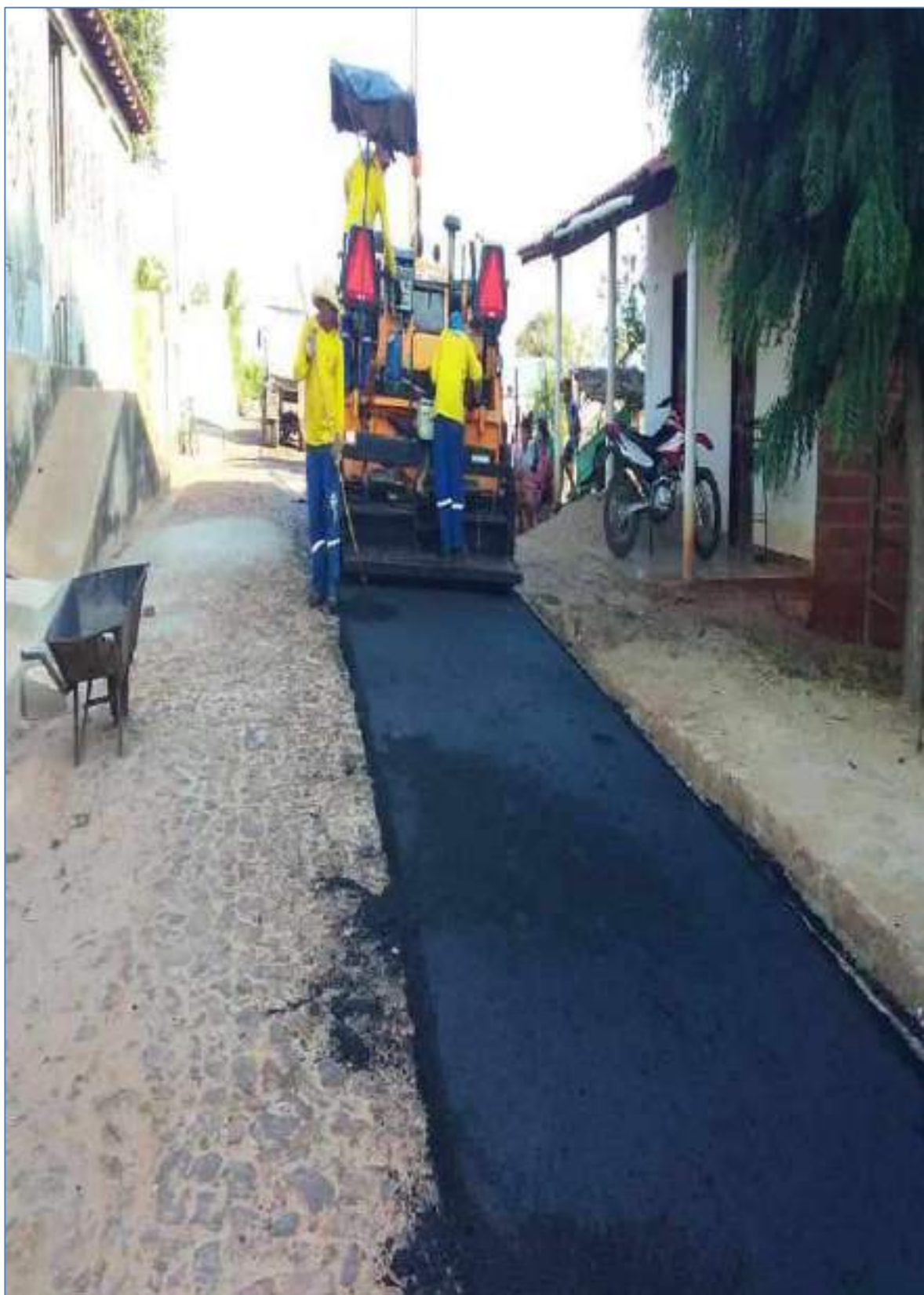
PAVIMENTAÇÃO ASFÁLTICA - ILUSTRAÇÃO: RICARDO SALES
