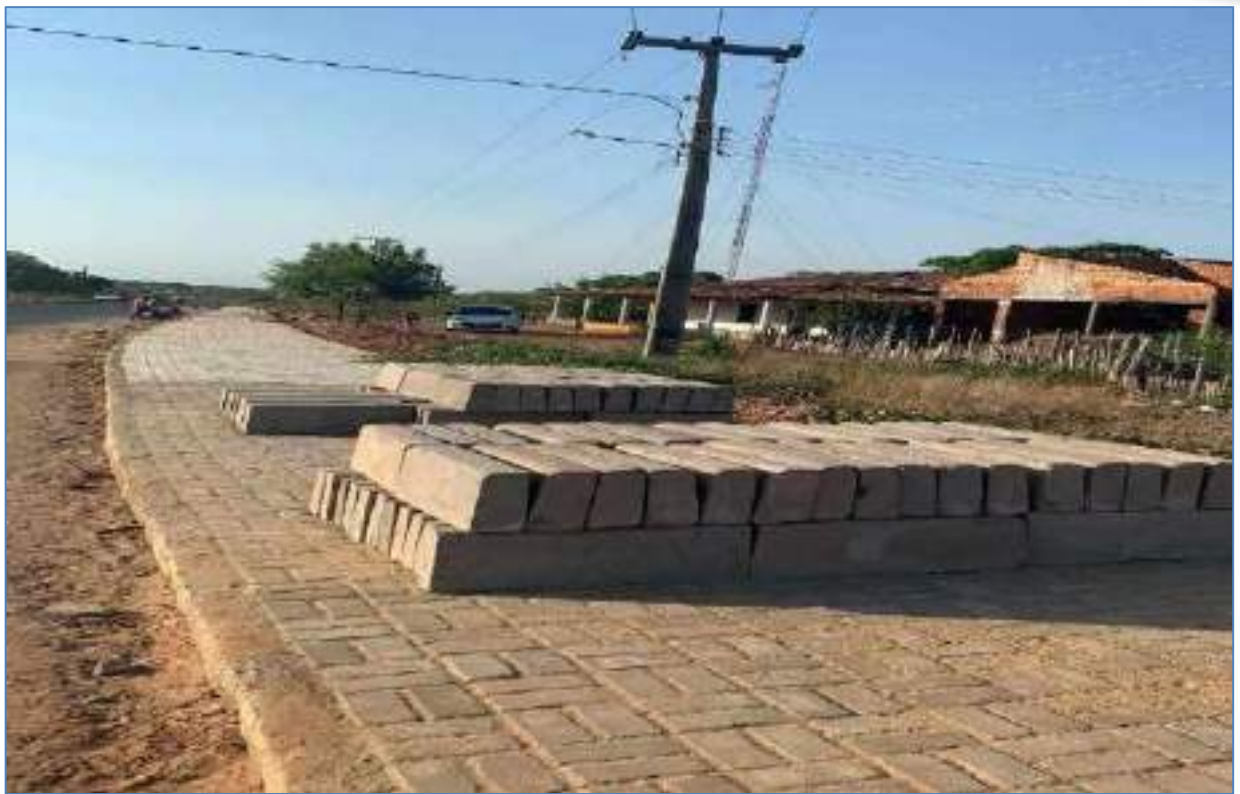
‘PAVIMENTAÇÃO POLIÉDRICA TIPO BLOQUETE (CALÇADÃO) NA SEDE – ILUSTR.:’
