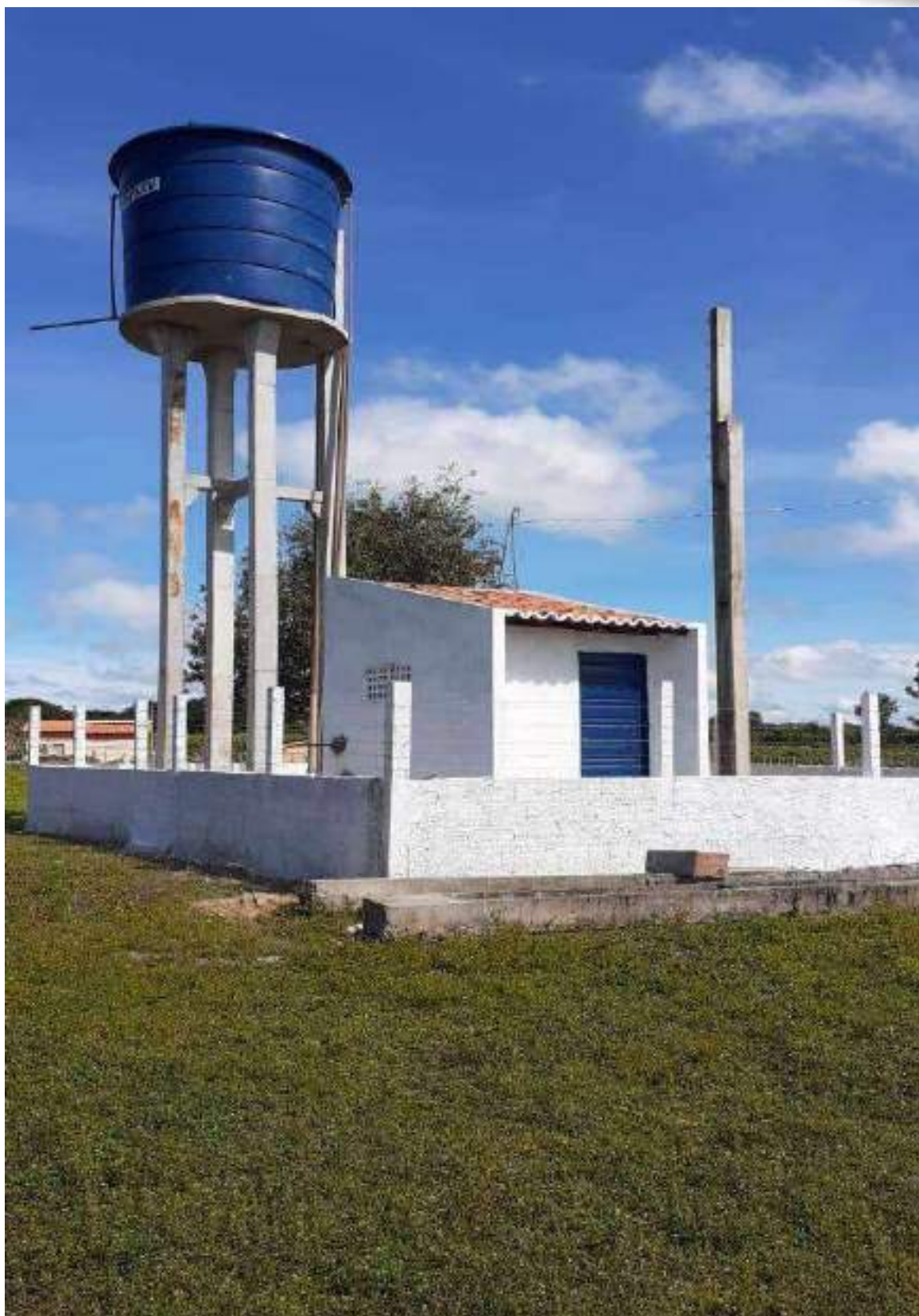
SISTEMA DE ABASTECIMENTO DE ÁGUA CONSTRUÍDO PELA PREFEITURA EM DIVERSAS LOCALIDADES (MODELO)/ ARQUIVO DA PREFEITURA
