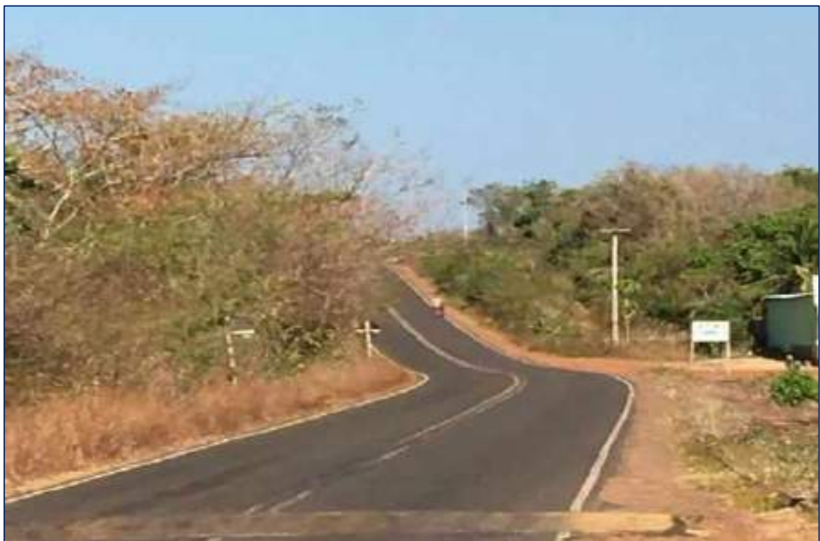
PI 211, Entrada que dar acesso ao município de Murici dos Portelas-PI - Ilustração: Lourdes Sales
