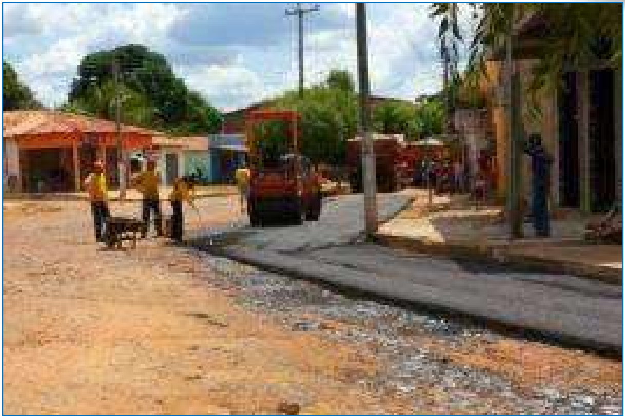
PAVIMENTAÇÃO ASFÁLTICA NA AVENIDA LIRA PORTELA – ILUSTR.: LOURDES SALES
