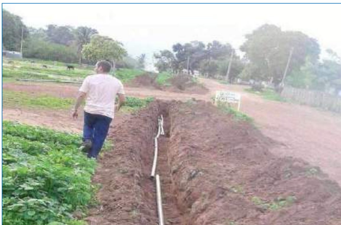
Instalação da rede de água na localidade, ao fundo prefeito Dr. Ricardo Sales/ Google
