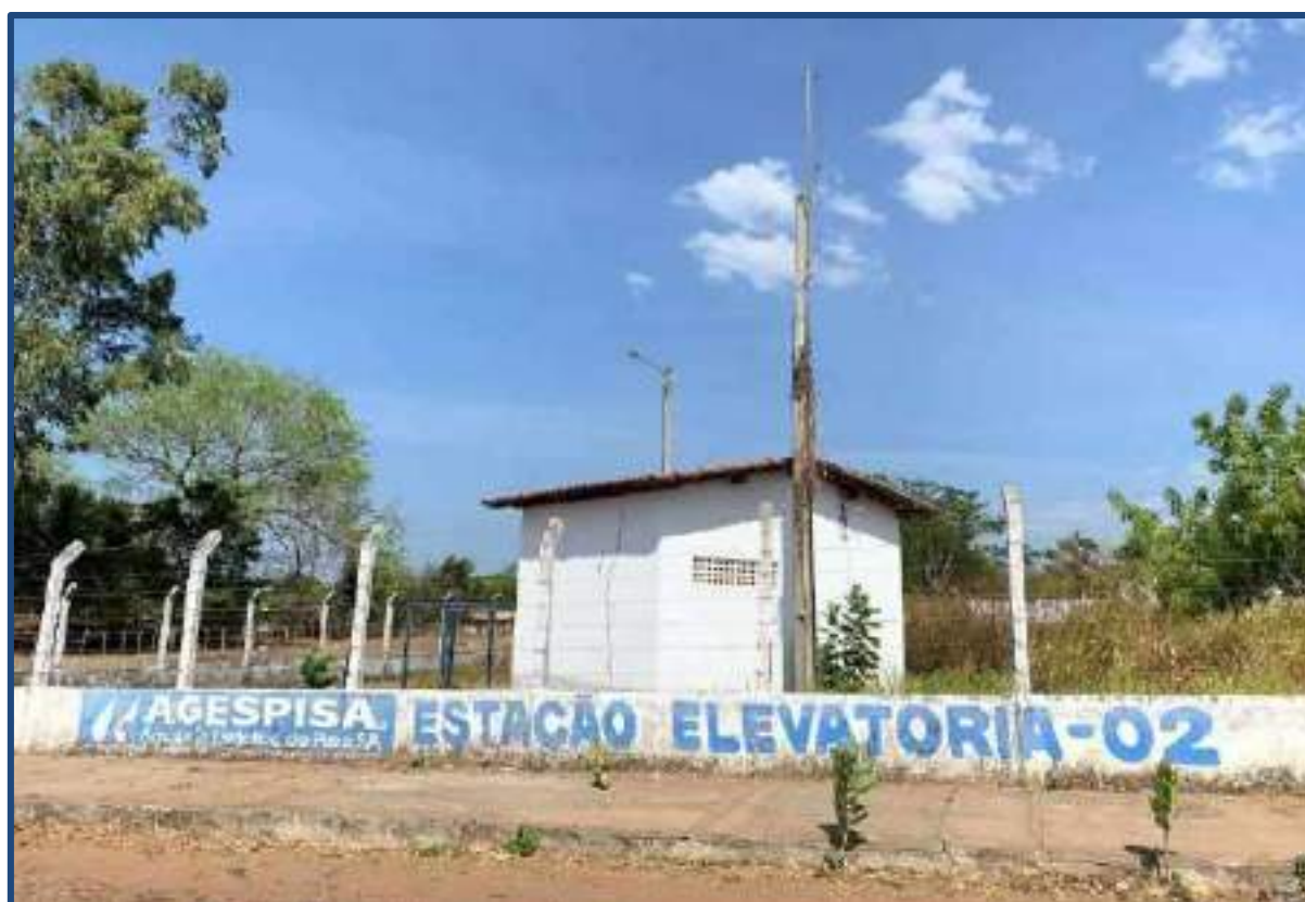
Estação Elevatória de Esgotamento Sanitário Nº 02 - Ilustração: Carlene Sales
