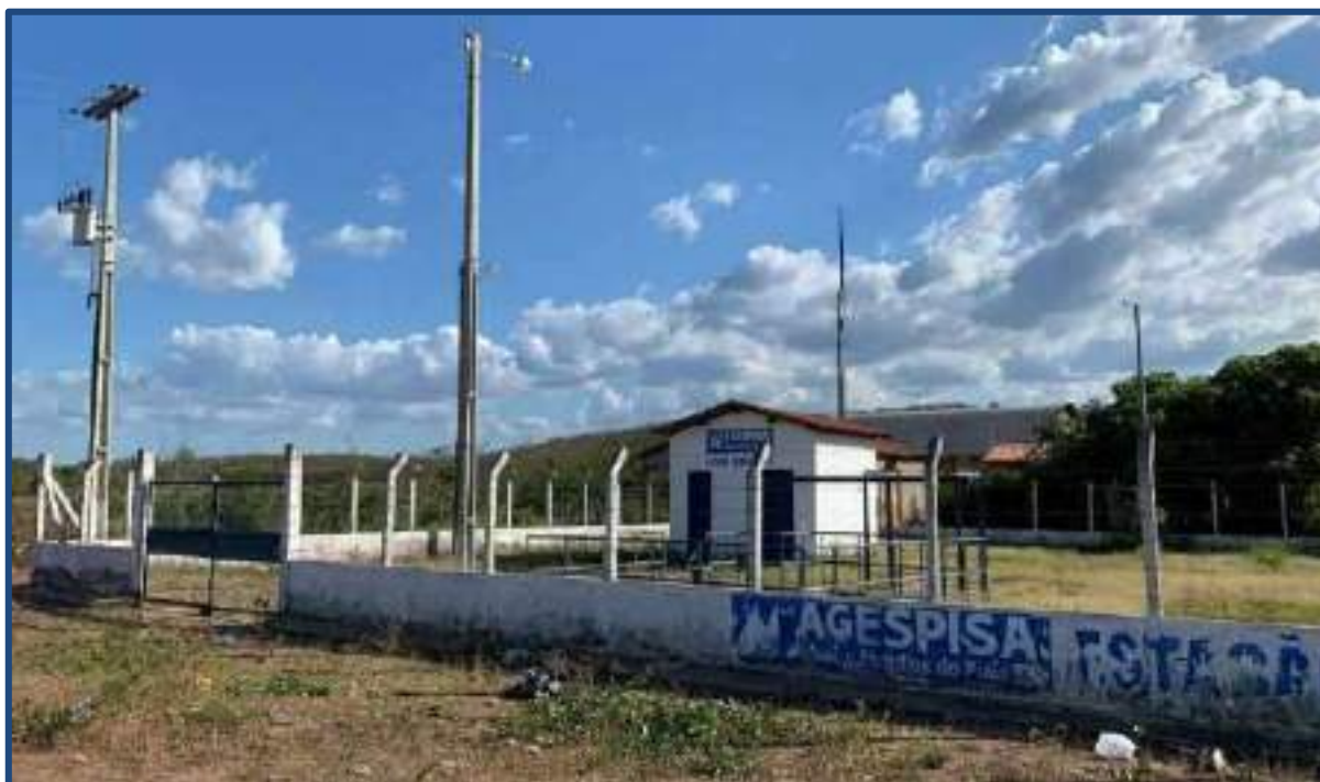
Estação Elevatória de Esgotamento Sanitário Nº 01 - Ilustração: Carlene Sales
