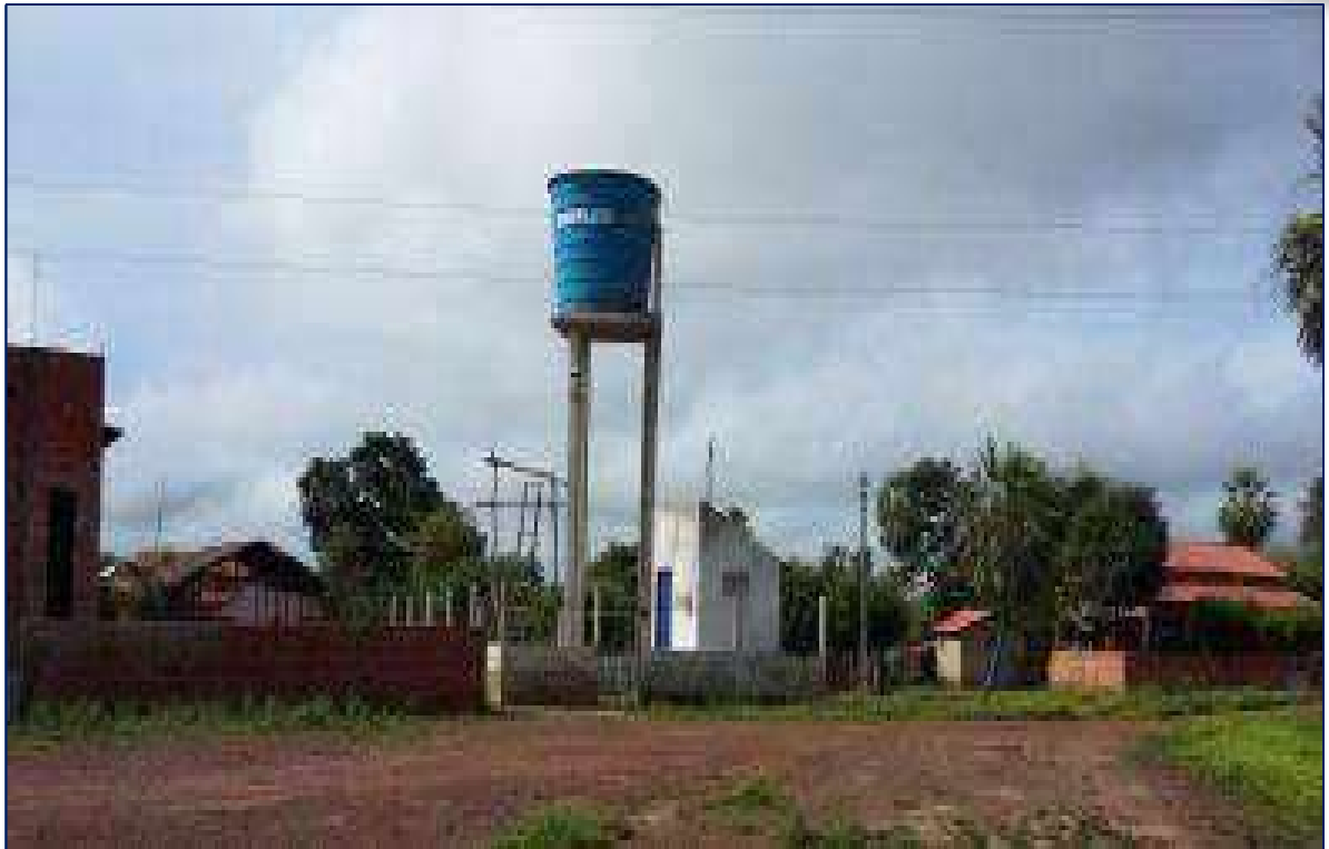
Sistema de distribuição de água da localidade (torre d'água) Comércio da localidade Covas
