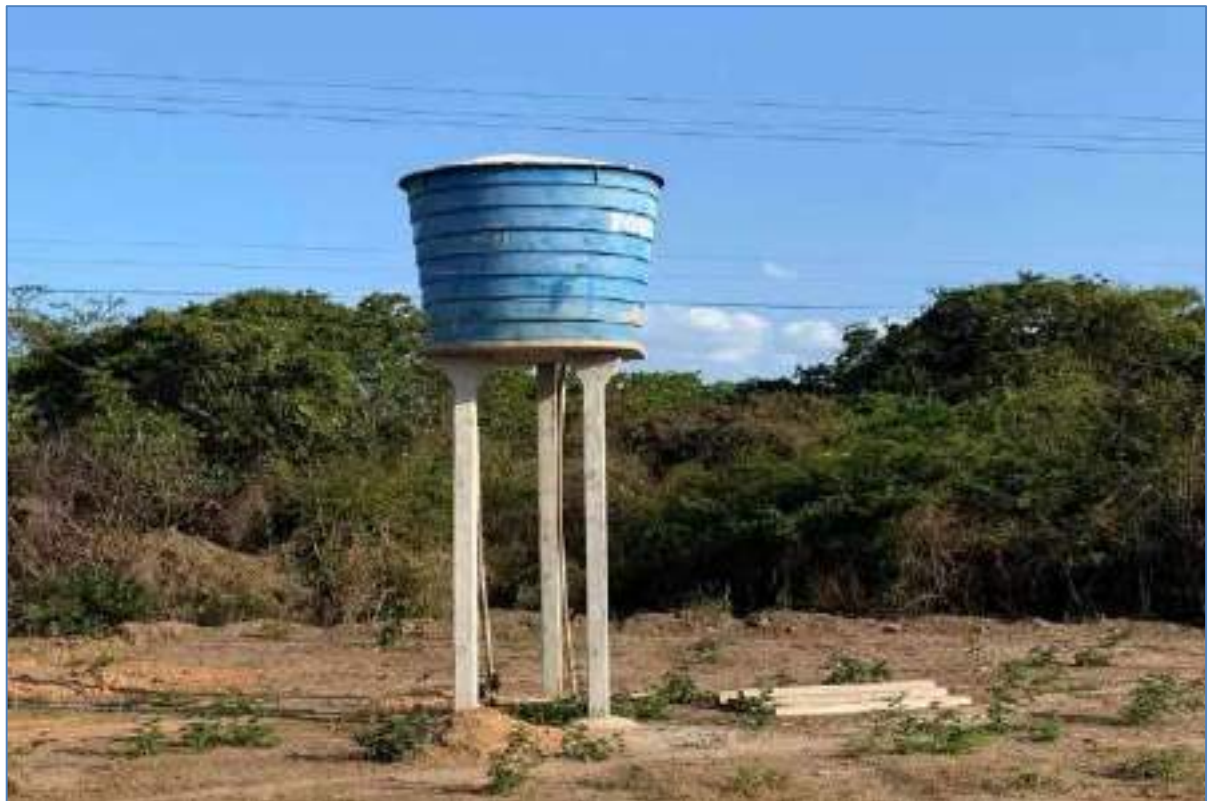
TORRE D'ÁGUA NA LOCALIDADE PORCOS
