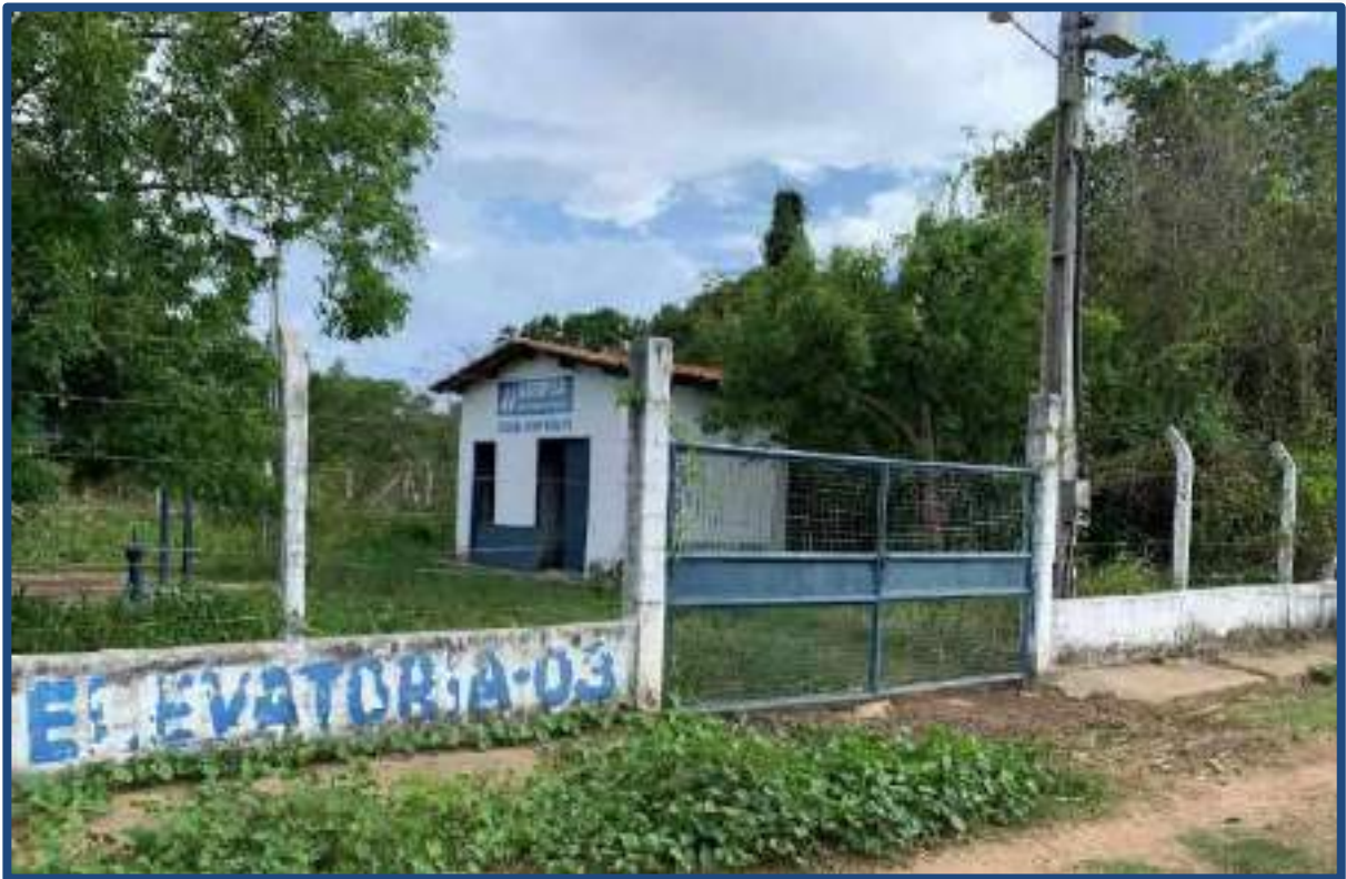
Estação Elevatória de Esgotamento Sanitário Nº 03 - Ilustração: Carlene Sales
