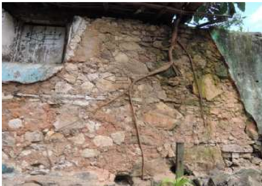
Imagem 11 - Tipos de materiais construtivos empregados na parede (Tijolos cozidos e Pedras de Rachão de Riólitos) – engenho Tabatinga-Ipojuca/ PE. Detalhe da espessura da parede (Janela)
