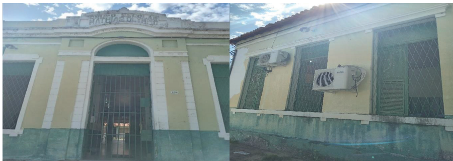
Foto nº 4: Porta principal e janelas do prédio Matias Olímpio. Fonte: Arquivo pessoal.
