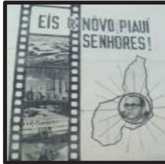
Foto 01: Propaganda do governo mostrando projetos e obras em andamento
