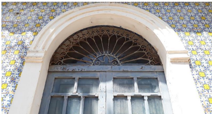
Figura 4: Detalhes de uma edificação com azulejos de fachada em Parnaíba (2021)
