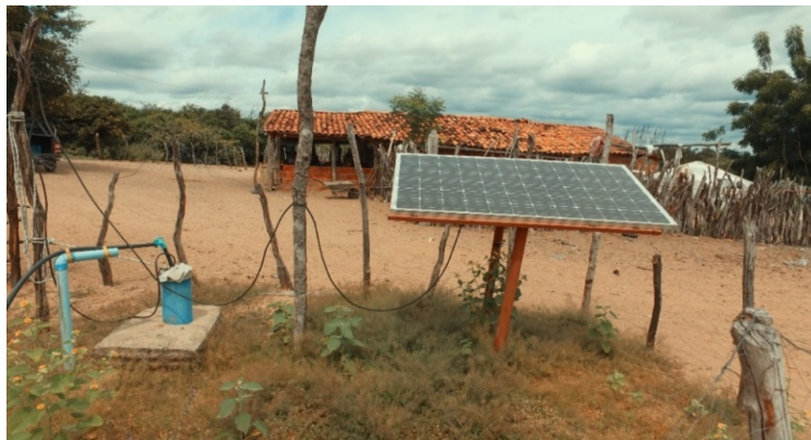
Figura 6 - Instalação de módulo fotovoltaico e conjunto motobomba.
