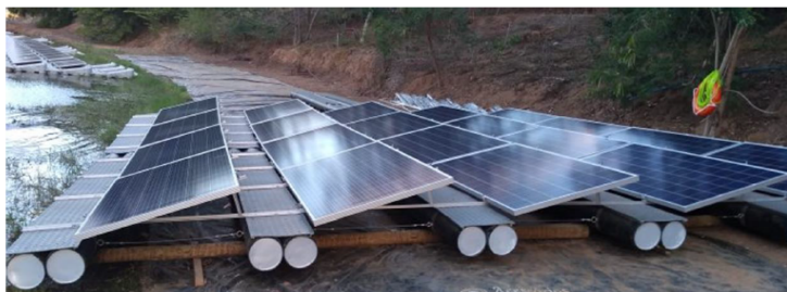
Figura 5 – Montagem final de um bloco de estrutura com 20 módulos.
