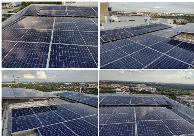
Figura 4 - Módulos após a limpeza
