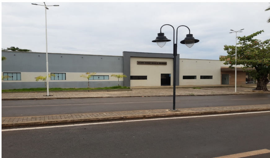
Figura 6 – Edifício Maria Assunção Furtado de Vasconcelos
