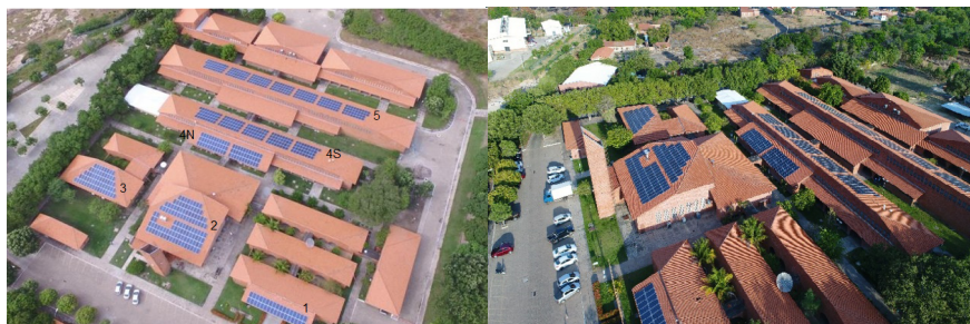
Figura 5 – Disposição do Módulos Fotovoltaicos da UFV – IFPI Campus Floriano
