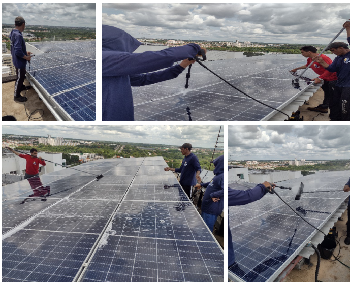
Figura 3 - Procedimento de Limpeza dos módulos
