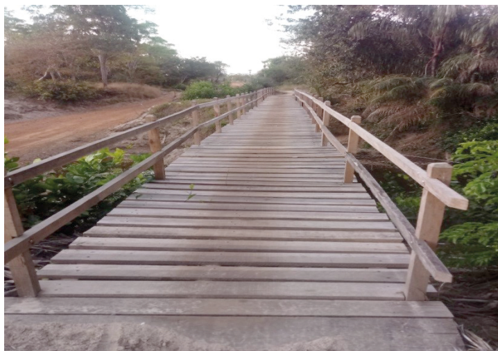
Foto - 1: Ponte de acesso à comunidade
