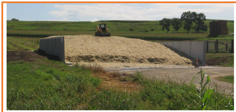
Figura 12 – Silo tipo Bunker.
