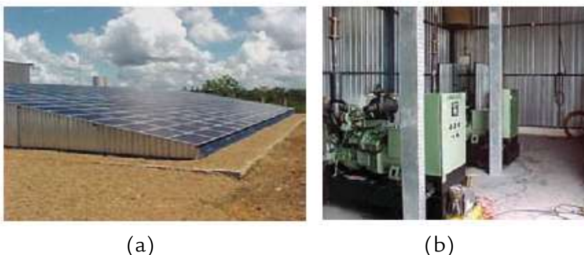
Figura 53 – Sistema híbrido solar fotovoltaico-diesel de Araras.
