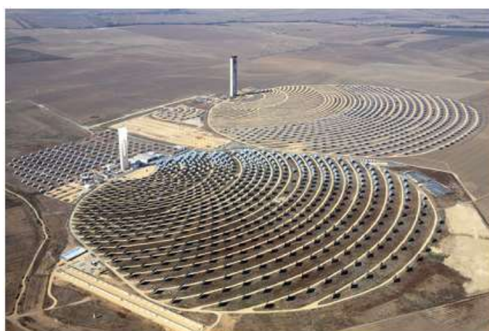
Figura 15 - Centrais solares de torre PS10 e PS20, Andaluzia, Espanha
