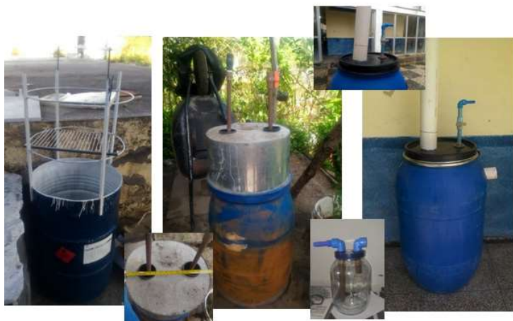
Instalação do 1º biodigestor
